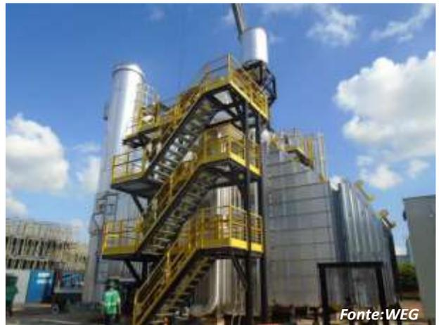
Dentro do reator, o CDR em contato com o leito fluidizado circulante, composto de sílica a 850°C juntamente com o ar de processo proveniente dos sopradores, transforma-se em um gás combustível através de reações químicas.
